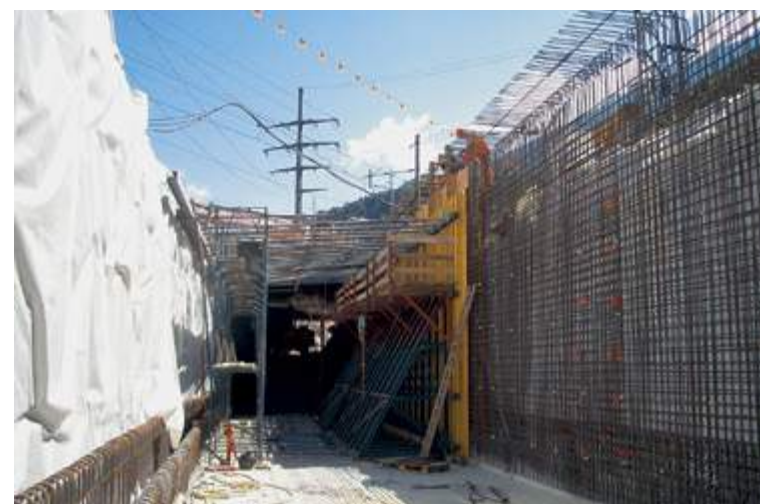
Ortsausfahrt Brig: Überquerung der SBB Strecke durch die MG-Bahn.
