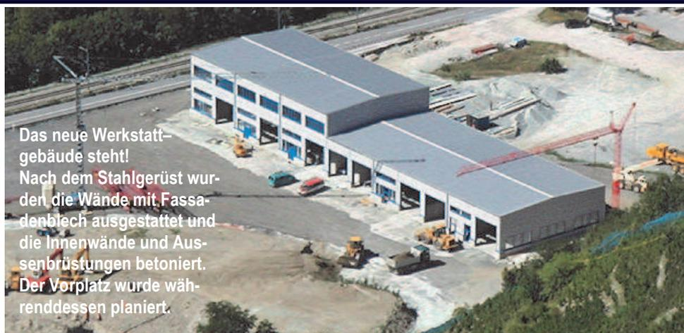
Das neue Werkstattgebäude steht! Nach dem Stahlgerüst wurden die Wände mit Fassadenblech ausgestattet und die Innenwände und Aussenbrüstungen betoniert. Der Vorplatz wurde währenddessen planiert.
