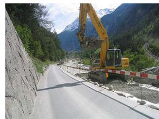
durch Geschiebe gibt, wird derzeit der Durchlass vergrössert. Bis jetzt konnten die Betonarbeiten der Durchlass-Strasse beendet werden. Derzeit ist die Bauequipe daran die Strassenkoffierung auf einer Länge von 200 Metern zu beenden und die Decke beim Durchlass abzudichten. Anschliessend folgen Betonarbeiten beim Einlauf Durchlass. Die Baustelle soll noch vor den Baumeisterferien im August abgeschlossen werden.
