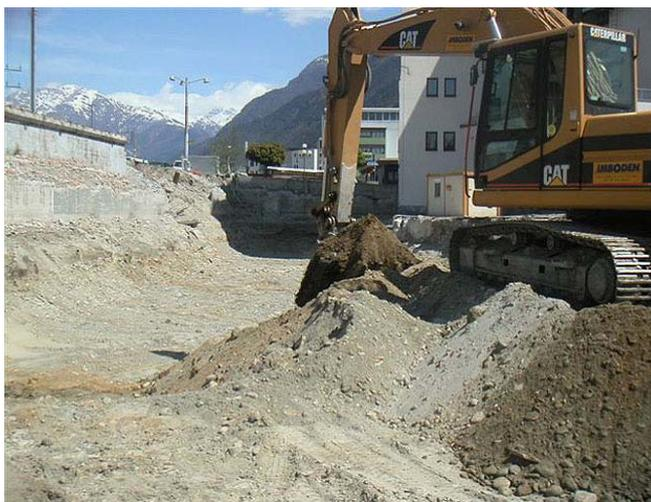
Am 24. April 2006 begann der Baugrubenaushub am Bahnhof Visp. Die Arbeiten umfassen neben dem eigentlichen Aushub von ca. 30'000 m<sup>3</sup> Erdmaterial auch der Abbruch der Unterführung zu den SBB Gleisen. Als Unterakkordant setzt die Spezialfirma Bauer Spezialtiefbau AG rund 100 Pfähle zur Stabilisierung des
