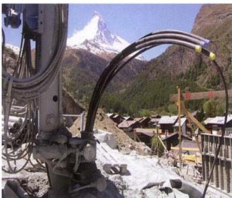
Gasser Felstechnik AG, Lungern, langjähriger Partner der Ulrich Imboden AG für Sprengarbeiten und Felsicherung, hat für eine Zermatter Baustelle der Ulrich Imboden AG ein neues Spezialbohrgerät für Erdwärmesonden-Bohrungen angeschafft. Dieses Bohrgerät hat sehr geringe Abmessungen und verfügt über vielseitige Einsatzmöglichkeiten im Bereich der Ankerarbeiten, aber auch im Bereich der Erdwärmesondenbohrungen mit Doppelkopfausrüstung.
