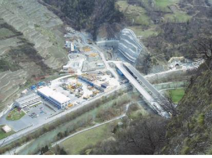
traditionellen Sprengvortrieb ausgebrochen. Derzeit sind rund 75 Meter geschafft. In Folge der sehr schlechten Geologie müssen die Tunnelleute alle 1.5 Meter ein Stahlbogen zur Sicherung anbringen und mit Spritzbeton auffüllen. Später mündet dieser Tunnel in die Südröhre im Tunnel Eyholz. Die Module zwei bis sechs dienen verschiedenen Verbreiterungs- und Verzweigungsarbeiten, u.a. auch für den Ausfahrttunnel und die Querschläge.
