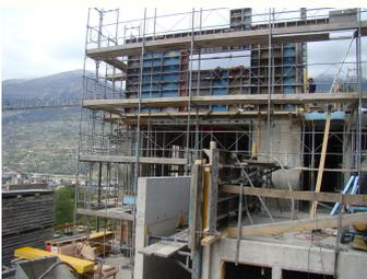
Das Einfamilienhaus «Wyer» in Visp ist eine Betonkonstruktion in Hanglage auf drei Geschossebenen. Dabei erfolgt die Zufahrt ab Strasse mit Garagenanschluss; der Wohn- und Essbereich wird im Erdgeschoss integriert, während dem im Untergeschoss Zimmer und Kellerräume vorgesehen sind. Bis Ende letzten Monats konnten die Rohbauarbeiten beendet werden. Diverse Umgebungsarbeiten dauern noch bis Mitte Mai.
