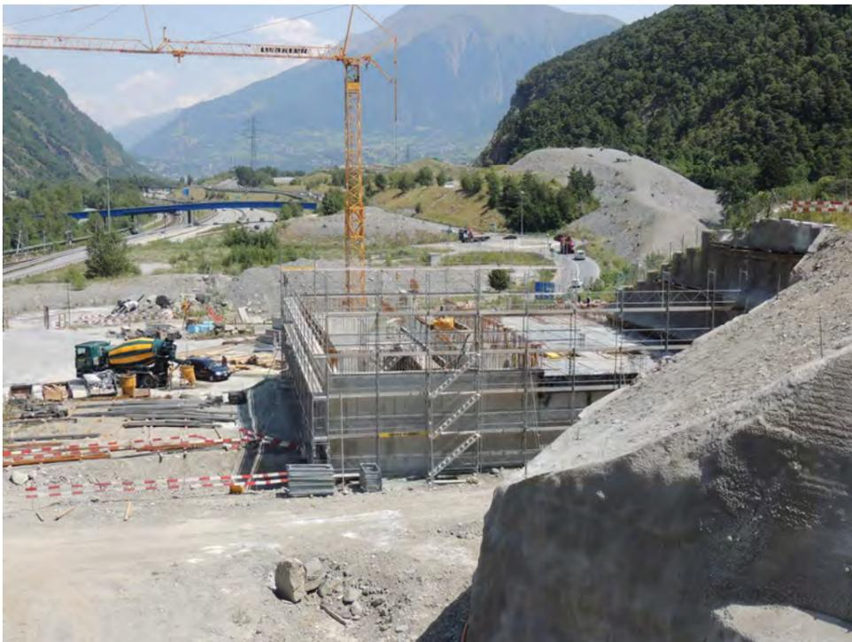
Die Lüftungszentrale «Grosshüs» ist ein Industriebau von 26 auf 21.7 Meter. Er wird im Tagbau ausgeführt und anschliessend grösstenteils zugeschüttet. Die Arbeiten begannen im April mit der Installation des grosszügigen Baustellenplatzes. Inzwischen ist das Erdgeschoss fertig betoniert. Die Lüftungszentrale bietet Platz für technische Installationen für den Betrieb der Zentrale Ost. Der Abschluss der Ar-
