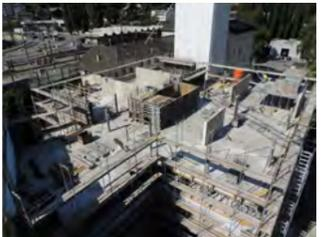
Programmgemäss sind die Schalungs-, Armierungs- und Betonarbeiten im 3. Obergeschoss in Ausführung. Mit dem 4. Obergeschoss werden die Rohbauarbeiten für den Neubau abgeschlossen. Anschliessend sind noch umfangreiche Umbauarbeiten im bestehenden Altersheim auszuführen.
