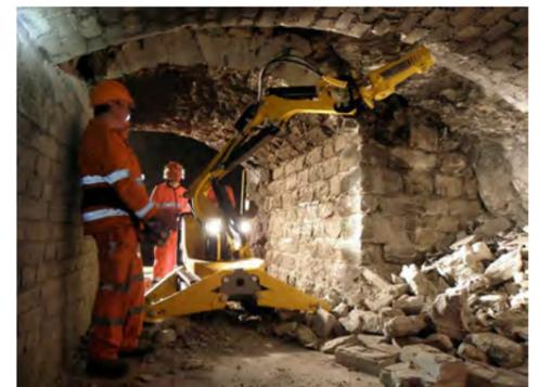
der neuen Querschläge wird zur Stützung des Mauerwerkgewölbes ein Betonring erstellt; der Ausbruch erfolgt dann mit Sprengvortrieb und Abbauhämmer. Die Querverbindungen werden beidseitig mit einer mechanisch selbstschliessenden Tür versehen. Gleichzeitig muss auch die Entwässerung angepasst werden. Das Entwässerungssystem muss je nach geologischer Beschaffenheit teilweise entkalkt oder erneuert werden.
