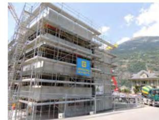
Die Rohbauarbeiten für das Mehrfamilienhaus Bäumgärten werden bis Ende August 2012 abgeschlossen. Zurzeit sind noch die Schalungs- und Armierungsarbeiten im Attikageschoss in Ausführung. Die letzte Betondecke konnte noch vor Beginn der Baufertigung erstellt werden. Derzeit kümmert sich die Bauequipe um den Innenausbau. Anschliessend sollen die Arbeiten für die Zufahrtsrampe in Angriff genommen werden. Der Abschluss der Bauarbeiten erfolgt Mitte Oktober 2012.
