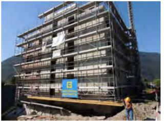
Mit der Fertigstellung der Zufahrtsrampe bis Ende Juli 2012 sind die Rohbauarbeiten für das Mehrfamilienhaus Chritzmatza abgeschlossen. Auszuführen sind dann noch diverse Zwischenwände sowie Zuputzarbeiten.
