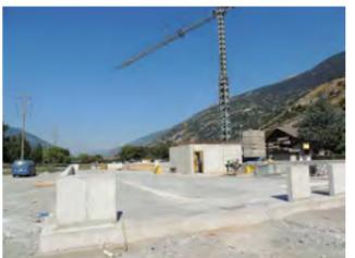
Die Bodenplatte mit einer Fläche von 900 m<sup>2</sup> ist erstellt. Zurzeit sind die Bauarbeiten infolge Planungs-Verzögerungen eingestellt. Per Mitte August sind noch die Wände im Treppenhaus, sowie die Betonarbeiten für die Zwischendecke auszuführen. Die Unternehmung mit dem Eigentümer Philipp Pfammatter ist als eigentliche Allroundfirma bekannt: Pfammatter Maler und Gipser AG malt, gipst, befestigt Hängedecken, giesst Bodengrundbelag und legt auch noch den Teppich oder den Lino.
