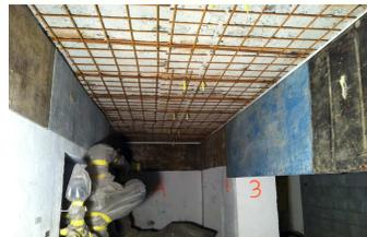
Beim Kraftwerk Ackersand wurden zwei Decken im UG der Zentrale saniert. Hierbei wurden zunächst der bestehende Mörtel abgespitzt, dann Armierungsnetze angebracht. Anschliessend wurde die Decke mittels Spritzbeton stabilisiert. Die Arbeiten dauerten zwei Wochen und konnten vor wenigen Tagen abgeschlossen werden.
