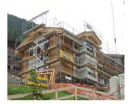
Die Holzbau AG aus Mörel erstellt in Zermatt ein Ferienhaus. Die Ulrich Imboden AG ist mit den Baumeisterarbeiten beauftragt worden. Dazu zählen Baugrubenaushub, Erstellen einer Stützmauer bergseits ca. 25m lang, das Erdgeschoss in Ortbetonbau, der Kanalisation und schliesslich Erledigen der Umgebungsarbeiten. Der Rest wird mit Fertigelementen erstellt.
