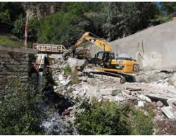
Der unterirdische Tunnel hat eine Länge von 135 Meter. Der Tunnel splittet sich in 35 Meter Sprengvortrieb sowie 100 Meter Tagbautunnel auf. Der Ausbruch und die Sicherungsarbeiten im Sprengvortrieb-Tunnel sind aktuell beendet. Die Entwässerung, das Einlegen der Drainageleitungen, die Spitzbetonverkleidung und die Betonsohle sind derzeit zur Hälfte ausgeführt. Für den Tagbautunnel muss ein Einschnitt mit Hangsicherung in den angrenzenden Fels gemacht
