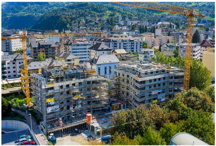
Mit dem Aushub wurde bereits Ende Oktober 2013 begonnen. Es musste ein gewaltiges Loch im Umfang von insgesamt 10'000 m<sup>3</sup> ausgehoben werden. Die Betonarbeiten konnten nach der Winterpause am 15.02.2014 in Angriff genommen werden. Insgesamt wurden 2'300 m3 Beton und 490 Tonnen Armierung verbaut. Dazu war Schalung im Umfang von 2'350 m<sup>3</sup> vonnöten. Zusätzlich wurden Mauern von insgesamt 4'200 m<sup>2</sup> erstellt.
