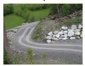
Beim Schutzdamm Eyholz sind sämtliche Arbeiten abgeschlossen. Hierbei wurde eine Dammschüttung von total 6'000 m3 vorgenommen. Zudem hat man eine 160 Meter lange Zufahrtspiste mit Rasengittersteinen erstellt.
