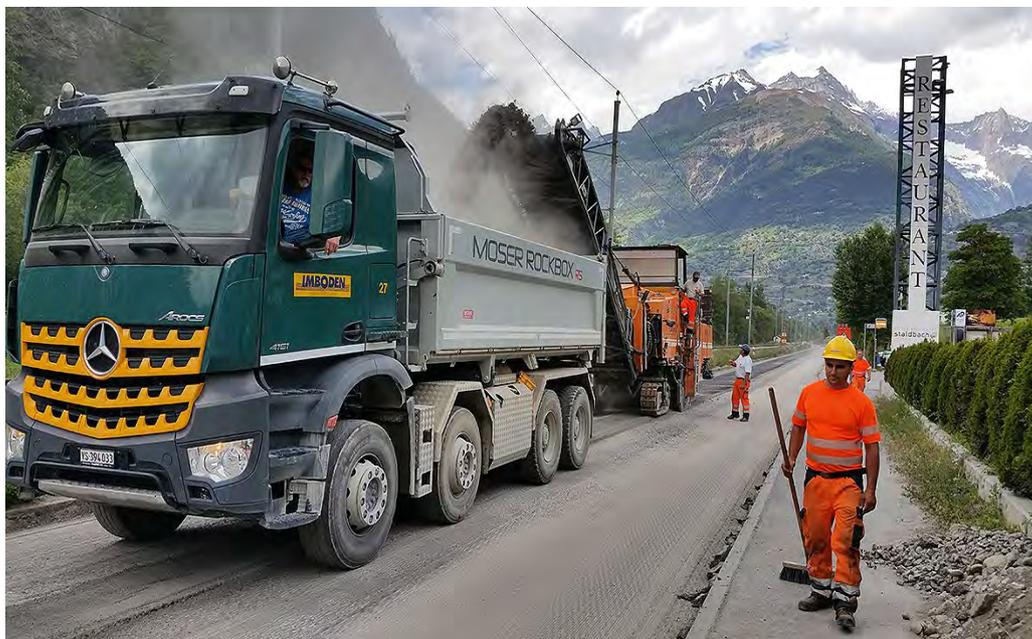
Am 01. Juni 2015 musste die Talstrasse ab 05.00 Uhr für jeglichen Verkehr gesperrt werden. Grund hierfür war das Herausfräsen der Deckschicht. Diese Fräsarbeiten wurden mit einer grossen Kaltfräse (40 Tonnen) ausgeführt. Die abzutragende Fläche betrug 11'000 m<sup>2</sup>; insgesamt wurden 1'320 Tonnen Material ausgebrochen. Dieses Material
