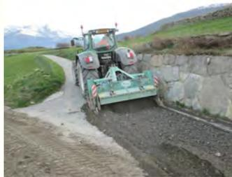
Seit dem vorletzten Jahr erneuert die Belagequipe das gesamte Flurstrassennetz in Ausserberg. 2015 muss der bestehende Belag aufgefräst und die Tragschicht ersetzt werden. Anschliessend werden die Unebenheiten ausgeglichen und rund 600 Tonnen Belag eingebracht. Zu einem späteren Zeitpunkt wird über die gesamte Strassenoberfläche eine Bitumschicht mit Einsplittung eingebracht.
