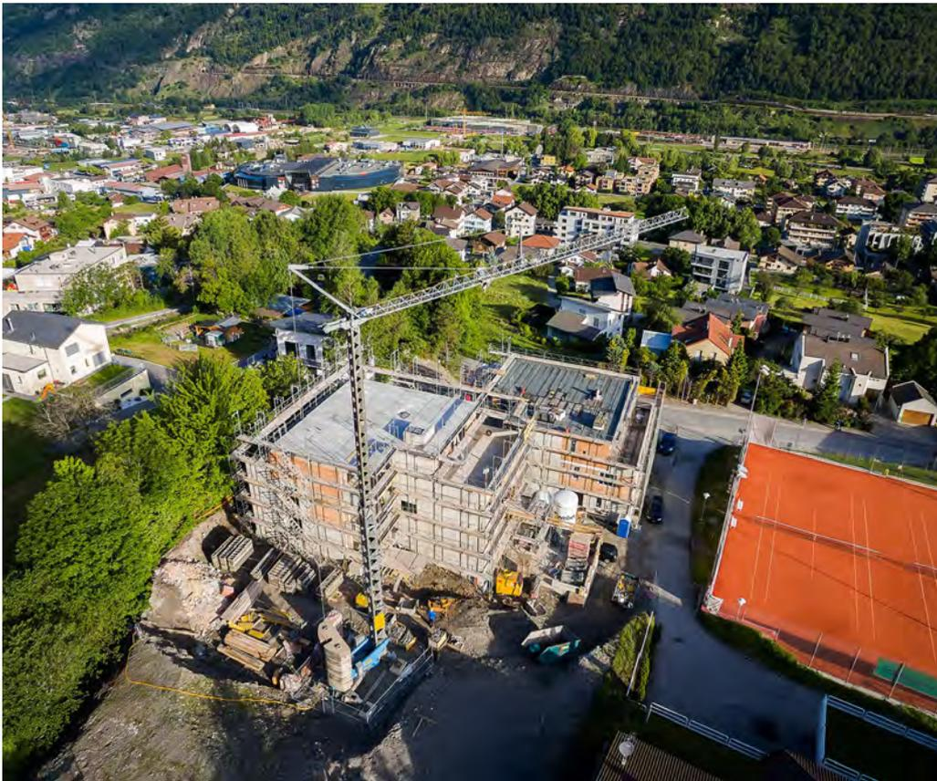
Bis zum Wintereinbruch erstellte die Equipe das Untergeschoss (Einstellhalle), das Erdgeschoss, sowie das erste Obergeschoss. Im März 2015 wurden die Arbeiten wieder aufgenommen. Inzwischen ist das Haus A mit zwei Geschossen erstellt. Das
