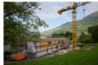
Beim Jugendwohnheim Mattini konnte der Rohbau gemäss Bauprogramm per Ende November 2014 fertiggestellt werden. Im April 2015 begannen die Aufbauarbeiten in Elementbau in Holz. Der Innenausbau erfolgt während dem Sommer. Nach den Sommerferien erstellt die Ulrich Imboden AG noch das Fassadenmauerwerk in Bruchstein, sowie notwendige Hinterfüllungs- und Umgebungsarbeiten.
