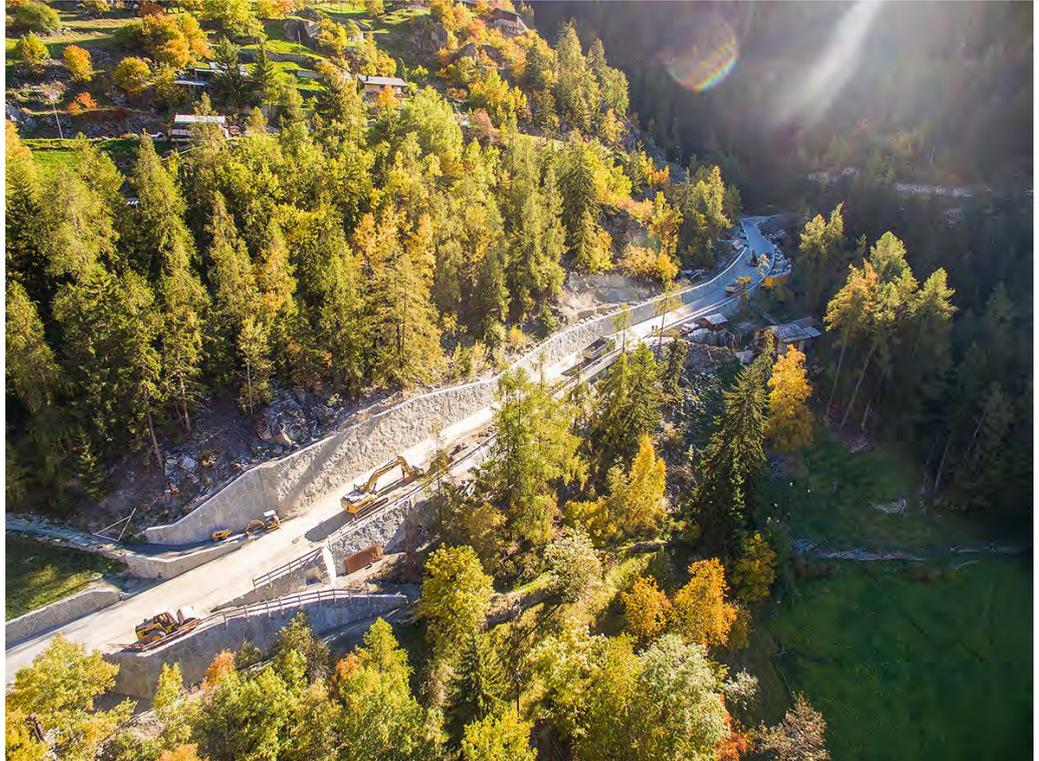
Das betreffende Los ist das mittlerweile dritte von fünf Losen. Diesmal wurde die Strasse auf einer Gesamtlänge von etwa 400 Metern erneuert. 2014 war der Streckenabschnitt Zermatt bis Bushaltestelle vorgesehen; 2015 dann der Abschnitt Bushaltestelle bis Abzweigung Bodmen. In einem ersten Teilstück 2014 erfolgte zunächst Abtrag und Aushub. Die Hangsicherung erfolgte mit Spritzbeton und An-
