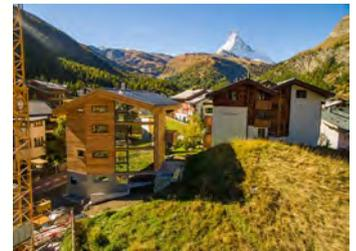
Bei diesem Neubau handelt es sich um ein fünfgeschossiges Einfamilienhaus. Das UG und das EG wurden in Massivbauweise, das 1., 2. OG und DG wurden mittels Fertigelementen erstellt. Das UG und EG wurden bis Ende Juni 2015 fertiggestellt, so dass ab Juli mit dem Versetzen der vorfabrizierten Holzelemente begonnen werden konnten. Das Haus ist ab November einzugsbereit.
