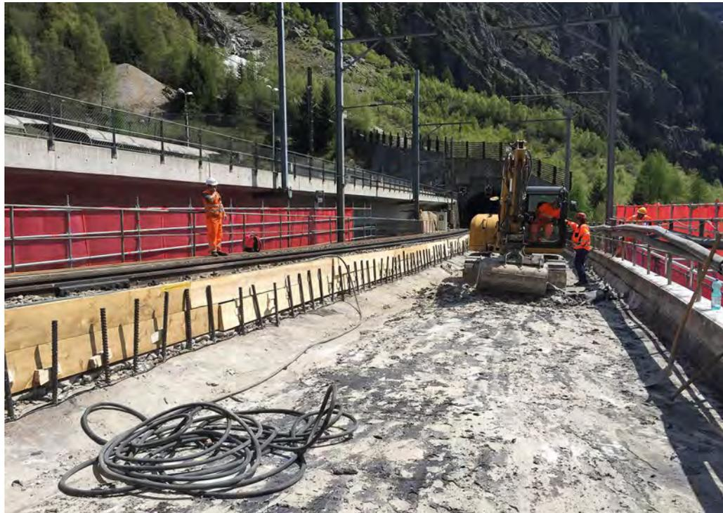
Das Lonzaviadukt der BLS befindet sich auf der Bahnstrecke zwischen Goppenstein und Hohtenn. Das Viadukt ist eine Natursteinbrücke, welche zu Beginn des 20. Jahrhunderts erbaut worden ist. 1970 wurde der Oberbau mit einem neuen Brückentrog und entsprechender Abdichtung ergänzt. Im Rahmen des Doppelspurausbaus der Lötschbergstrecke wurde 1980 auf der Westseite anliegend zur Natursteinbrücke eine neue Betonbrücke erstellt.
