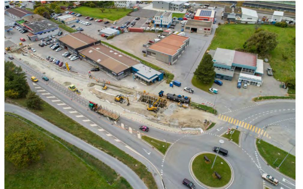
Am 22. Juni 2017 erhielt die Ulrich Imboden AG den Zuschlag für die Sanierung der T9 im Abschnitt Autoelektrohenzen - Kreisel Lalden. Der Abschnitt hat eine Länge von 417m. Es handelt sich um eine Oberbauanierung mit Belag, Fundationsschicht inklusive Geogitter und Geotextil. Im Weiteren werden im Strassenbereich die Infrastrukturanlagen erneuert. Will heissen Strassenentwässerung, Entwässerung der Ge-
