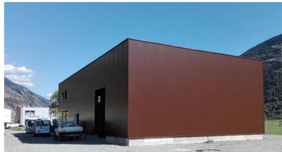
Nach Erstellung der Bodenplatte mit einer Fläche von etwa 420m<sup>2</sup> wurden die Brüstungen betoniert. Danach überliess man die weiteren Arbeiten den Zimmermännern, welche die Halle in Holz erstellten. Während dem Open Air konnte man auf der
