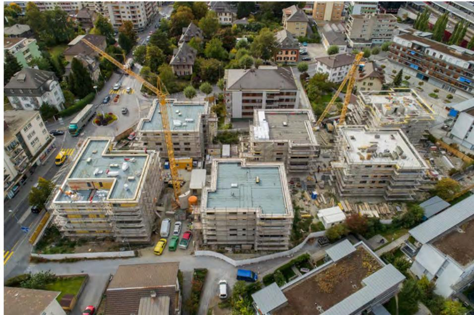
Der Rohbau der Wohnüberbauung «Bäret» der Pensionskasse der Lonza kann termingerecht fertiggestellt werden. Die letzte Decke wird ca. Mitte Oktober 2017 betoniert. Anschliessend wird noch alles ausgeschalt und die Zwischenwände erstellt.
