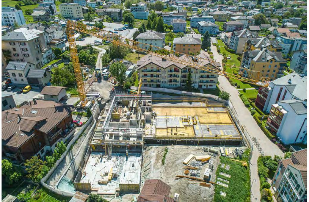
Die Imvista SA erstellt auf den Planungsunterlagen von Balzani Architekten diese Überbauung. Die Wohnanlage besteht aus einer Tiefgarage mit insgesamt 41 Parkplätzen, diversen Technikräumen, Kellern und einem Luftschutzraum. Verteilt auf das Erdgeschoss, das 1. und 2. Obergeschoss und das Attikageschoss entstehen insgesamt 54 Wohneinheiten. Die Masse
