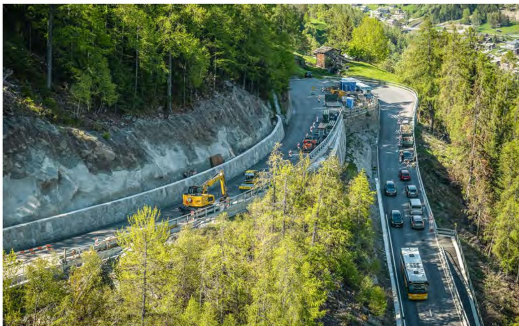
Mit dem Ausbau des ca. 260 m langen Abschnittes der Strasse St.Niklaus – Grächen, Abschnitt Riedacher, wurde im Juni 2020 begonnen. In der ersten Etappe wurden die bergseitigen Spritzbeton- und Ankerarbeiten ausgeführt, bevor mit der Futtermauer begonnen werden konnte. Die Sicherungsarbeiten gestalteten sich als aufwendig, da der angetroffene Fels bei weitem nicht so standfest war, wie angenommen. Dieser Umstand führte dazu, dass die Sicherungsarbeiten doppelt so viel Zeit in An-
