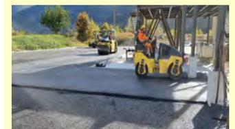
Die Lonza AG ist in diesem Bereich der grösste Auftraggeber. Beim sogenannten Brandübungsplatz wurde ein Sickerbelag im Umfang von 9'000 m<sup>2</sup> eingebaut.
