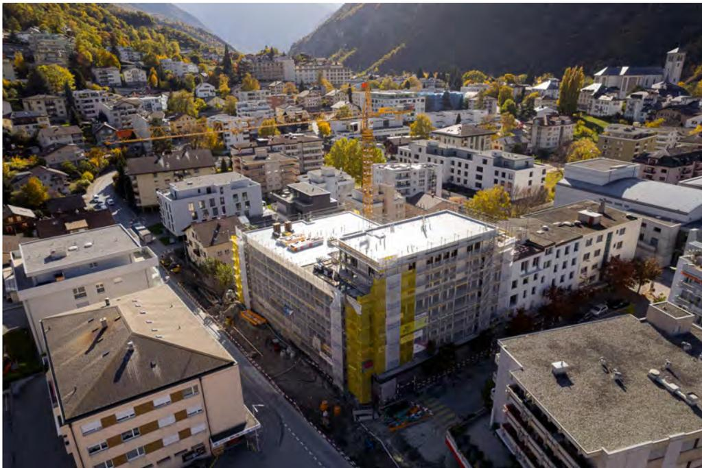
In der Überbauung «Visp City» entstehen insgesamt 40 Wohneinheiten. Bauherr ist die Imvista Development AG. Die verbauten Mengen sprechen eine eindruckliche Sprache: Insgesamt brauchte man 17'000 m<sup>2</sup> Schalung, 3'700 m<sup>2</sup> Beton und 510 to Bewehrung. Verbaut worden sind 280 vorfabrizierte Stützen und 15 vorfabrizierte Treppen.
