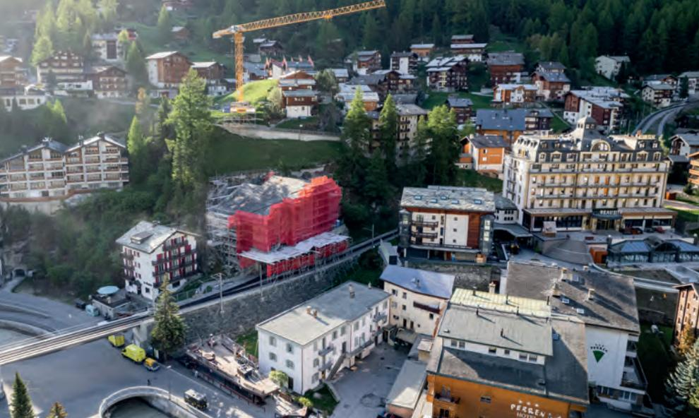
Die Baustelle wird über die darüberliegende Riedwegstrasse beliefert. Bis Mitte Juni konnten die Abbrucharbeiten durchgeführt werden. Die Baustelle ist mit über 20 Mann sehr personalintensiv. Mit zwei Beton-Trenn-Arbeitsgruppen wurden sämtliche Balkonbrüstungen entfernt und die Kernbohrungen für die neuen Steigleitungen erstellt. Zeitgleich mit den Abbrucharbeiten werden die Innenmauerwerke aufgemauert. Bezugstermin der neuen Wohnungen ist auf Herbst 2022 geplant.
